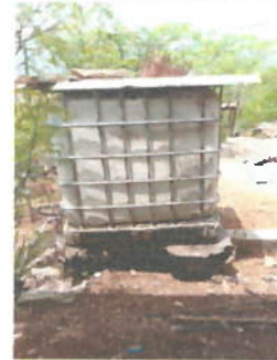
Foto 4: Sustitución de cisterna y accesorios de tanque de almacenamiento de agua.
