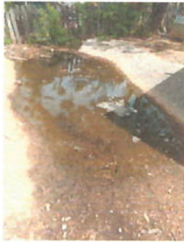
Foto 3: Mantenimiento a fosa séptica.
