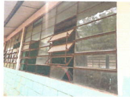
Foto 2: Mantenimiento a balcones metálicos, incluye: soldaduras, lijado y pintura.
