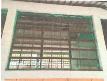
Foto1: Sustitución de ventanas; sistema de apertura: Corredizas, Perfiles color blanco estandar, Material del marco: PVC Material de la ventana: Vidrio, sellado perimetral.
